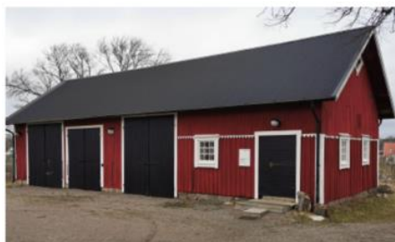
Bild. Ladugård som flyttas.
